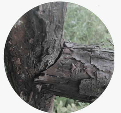
Rinde an der Pfosten-Riegel-Konstruktion
